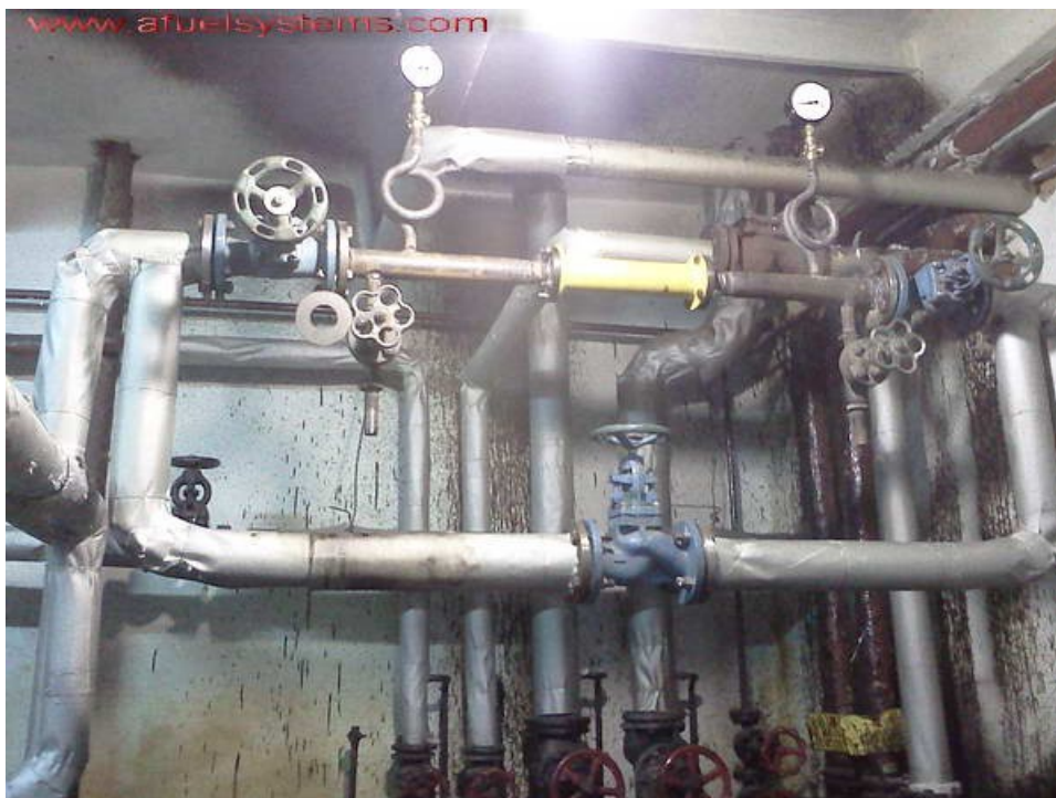
активатор TRGA с производительностью 5 м. куб в час
