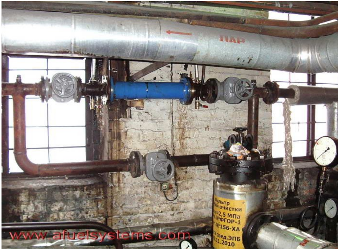
активаторы TRGA с производительностью 20 м. куб в час
