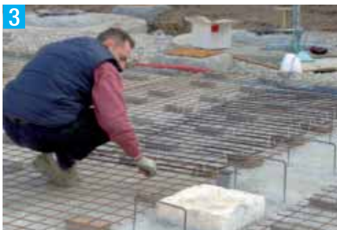
3 - 4) Stesura del cavo scaldante Laying of heating cable
