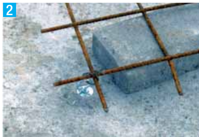
2) Fissaggio della rete elettrosaldata Fixing of welded mesh
