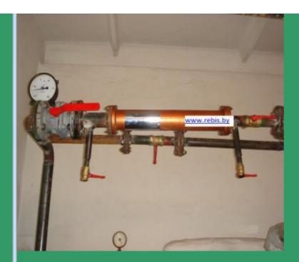
Уже после установки гомогенизатора решился проблемный вопрос о сжиганию обводнённого мазута. Вода, которая отделялась после фильтра и выносилась "вёдрами"- не выделяется,а обрабатывается и отправляется на сжигание. Так же стало возможным подмешивать в обводнённый мазут отходы ликёро-водочного производства (сивушных масел).
